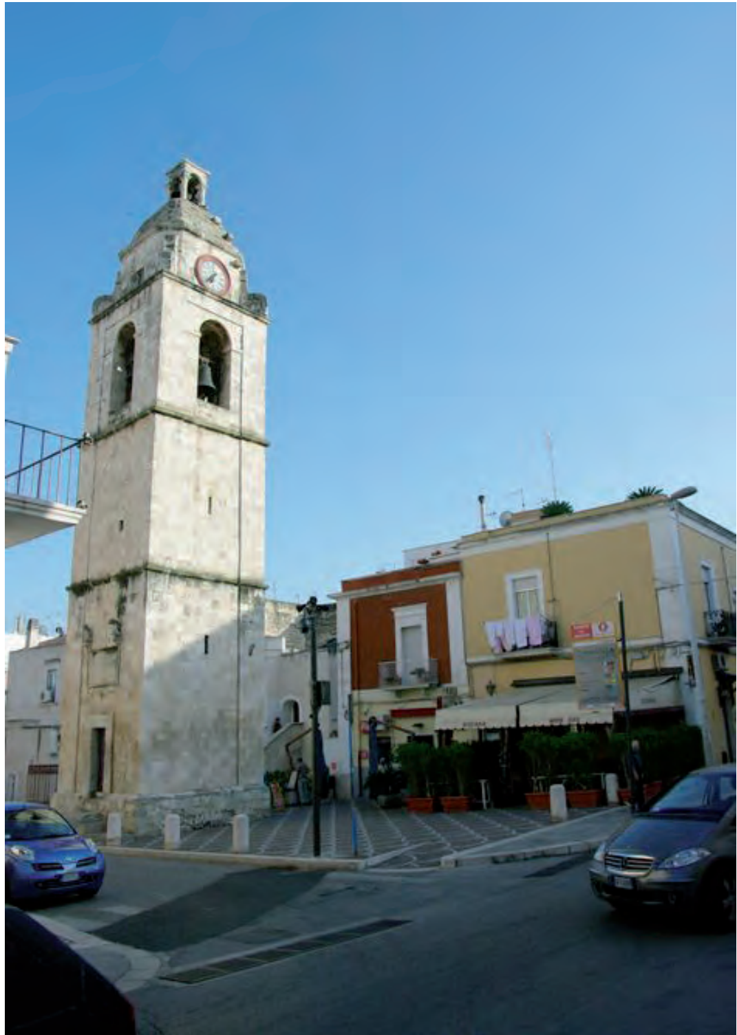
Esempio di occupazione di suolo pubblico con attrezzature fisse che interferiscono con la lettura del monumento.
