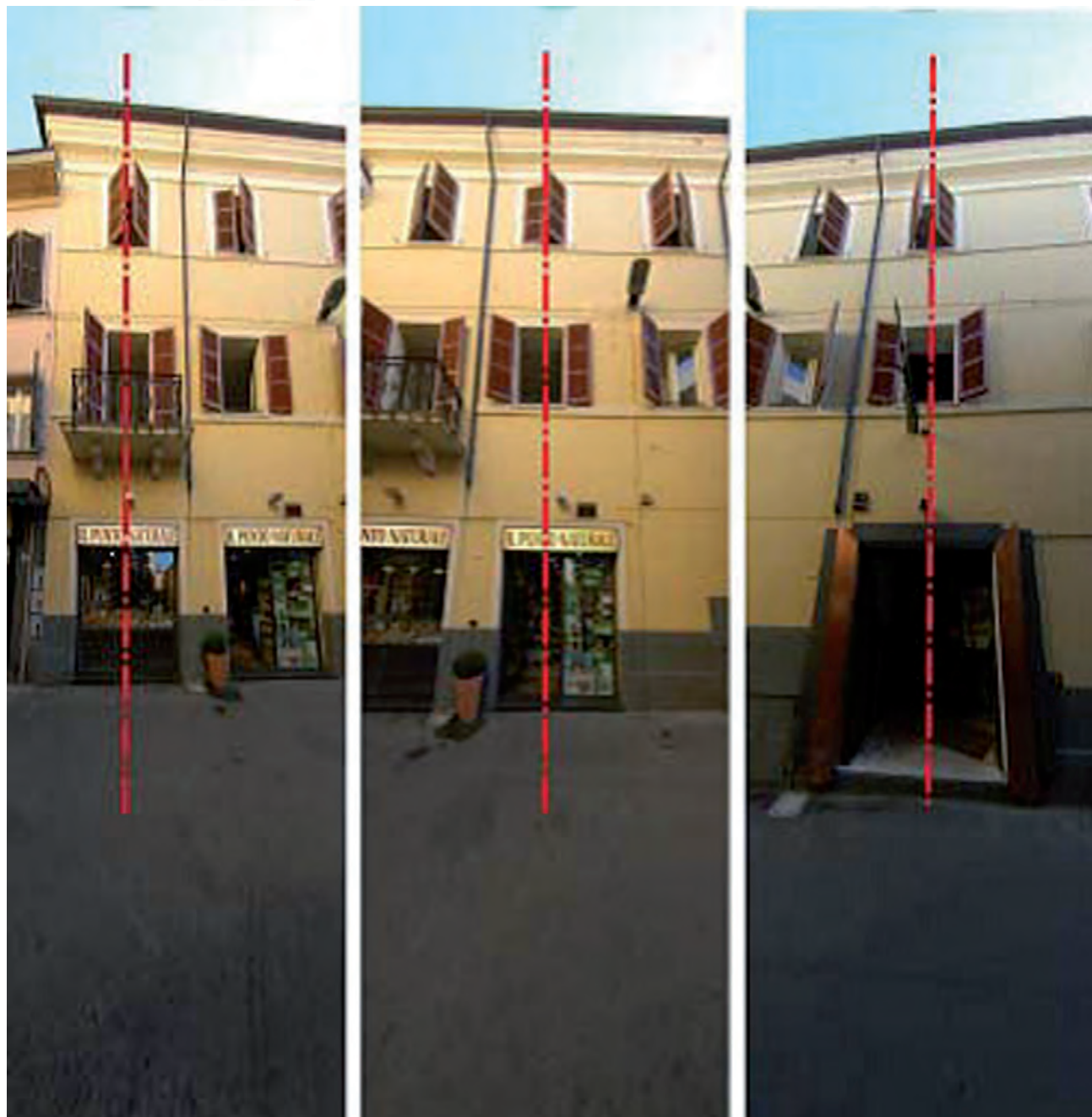
Condizioni di ripresa: allineamento l'asse ottico della camera alle forature e aggetti prevalenti; orientamento verticale per inquadrare l'intero fronte
